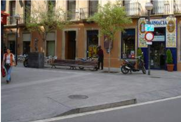
Carrer Sant Antoni Maria Claret: entrada en la zona de vianants senyalada per la sobrelevació de la calçada i senyalització vertical
