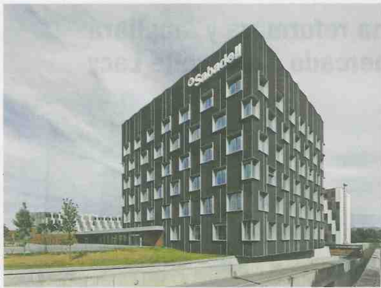
Centre corporatiu del Banc Sabadell a Sant Cugat
