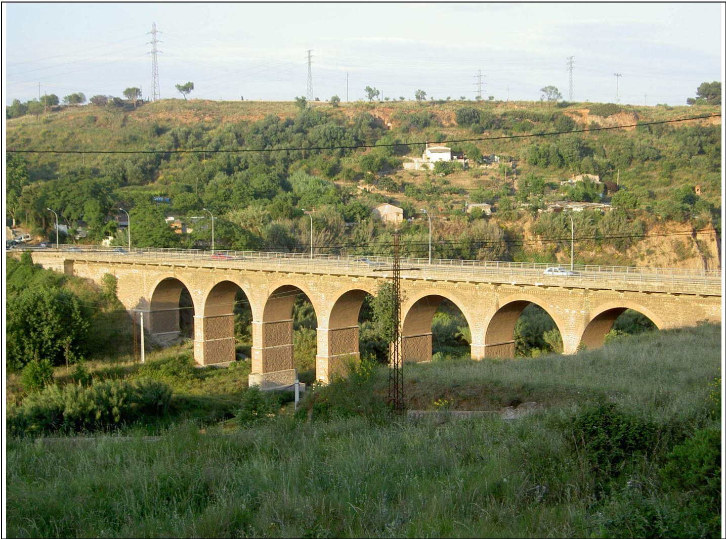
Pont ubicat a la carretera de Caldes per salvar el riu Ripoll. Aquesta obra va assenyalar l'inici de l'obertura de la carretera de Sentmenat i Caldes de Montbui, i va afavorir la ubicació del cementiri a l'altra banda del riu Ripoll. El pont té divuit metres d'alçada i està sustentat per vuit arcs de set metres de llum.
