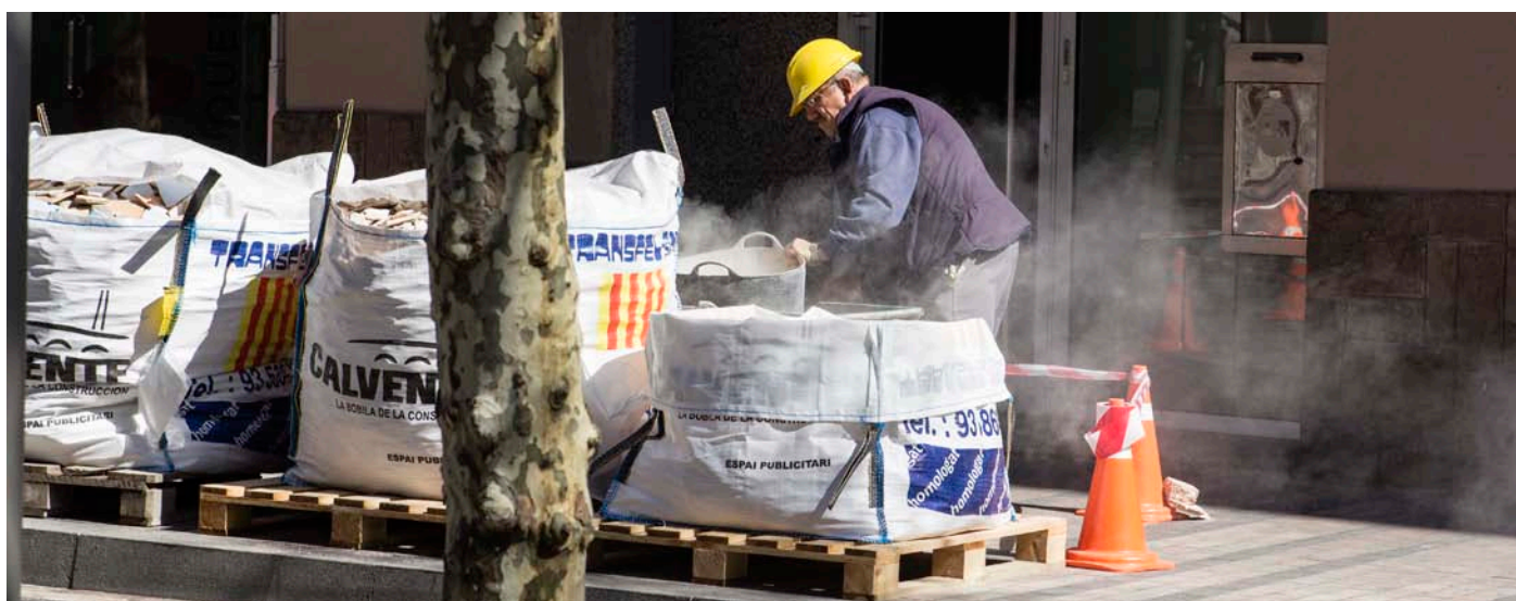
Figura : Activitat de construcció/demolició a la via pública. Font: BCNecologia
