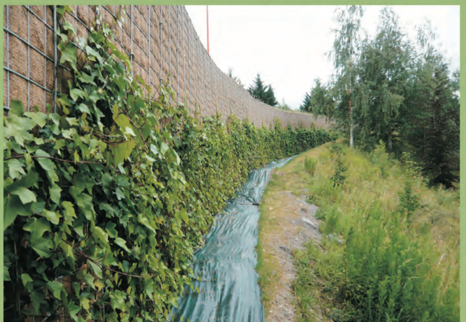
Barrera Acústica Vegetal después de 1 año
