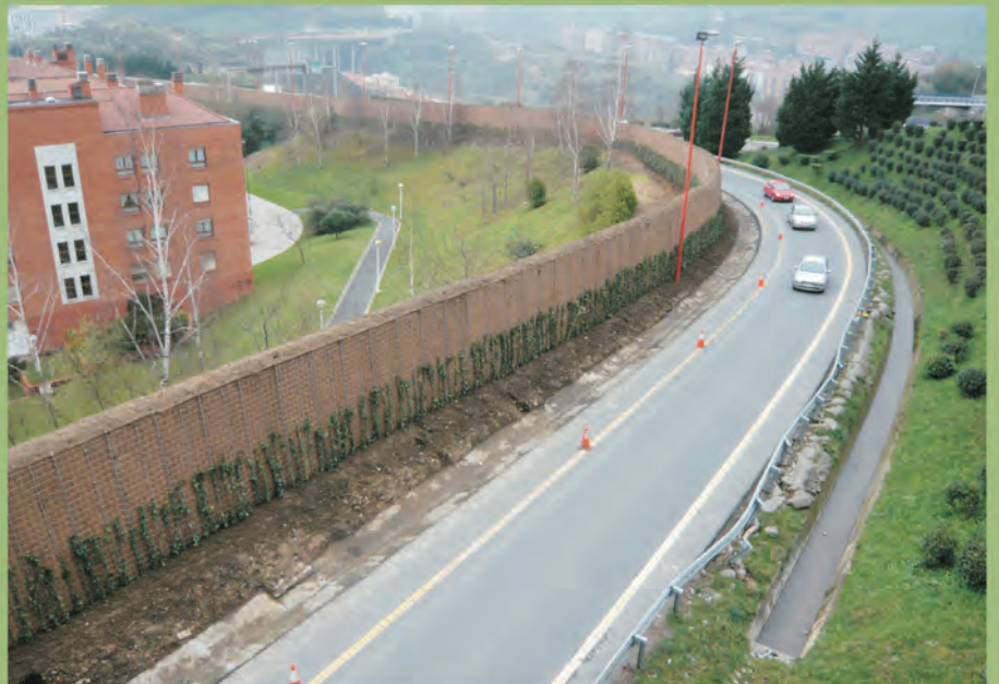
Barrera Acústica Vegetal con plantas el día de la entrega obra
