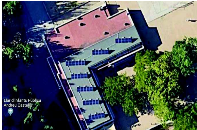
Imatge 34: Instal·lació fotovoltaica a Andreu Castells
