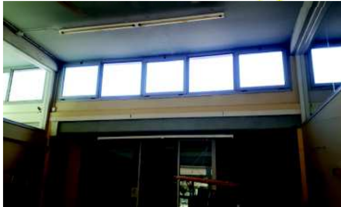
Imatge 30: Finestres abatibles no motoritzades
