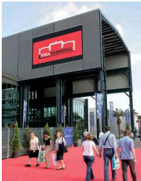
La transformació de l'antiga ABB en el Centre Firal i de Congressos de Sabadell ha rebut el premi Bonaplata a la millor restauració industrial
