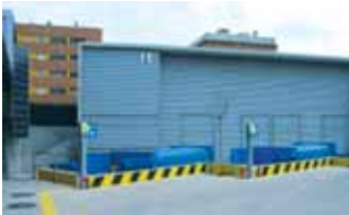
Deixalleria de Can Llong
