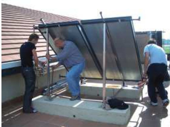
Cursos de formació d'instal·ladors al Parc Central del Vallès
